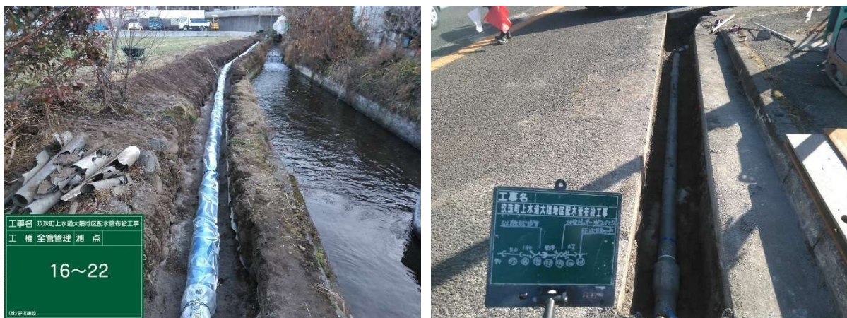
写真-1 拡張工事の様子
