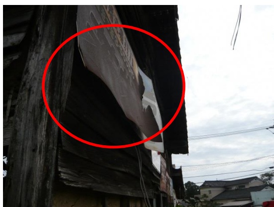
鉄製看板落下の危険性
