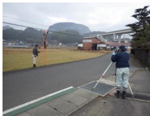
測量の様子 (現場)
