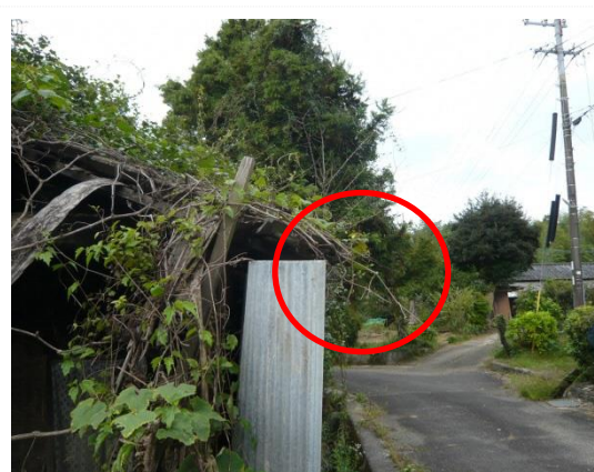
枝等が道路にはみ出している
