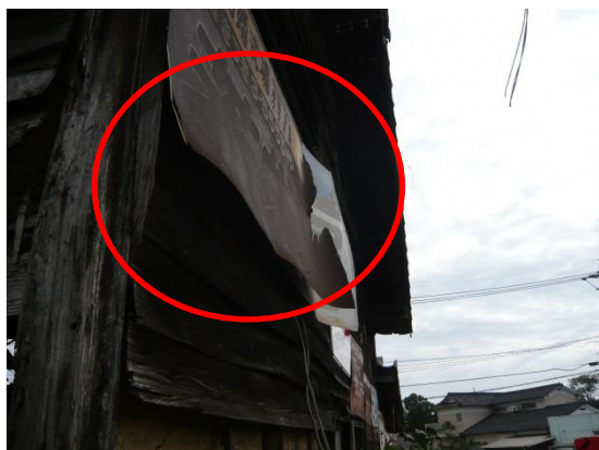
鉄製看板落下の危険性
