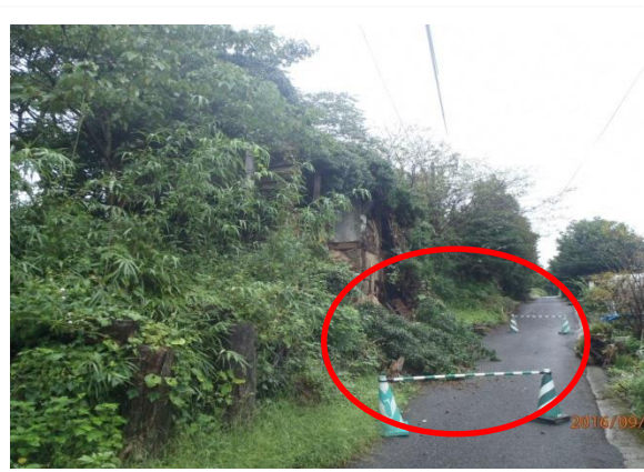
立木が倒壊し道路を一部塞いでいる
