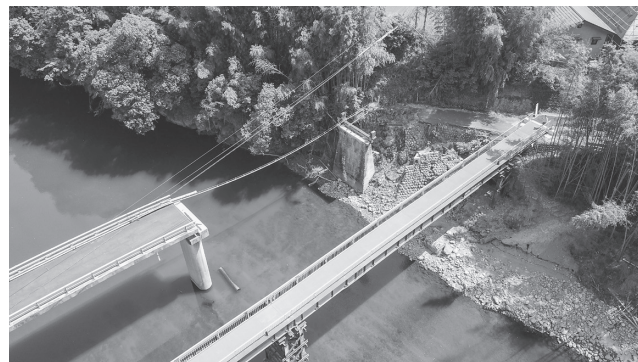
令和2年7月豪雨災害復旧事業 下泊里人道橋(仮橋)設置工事
