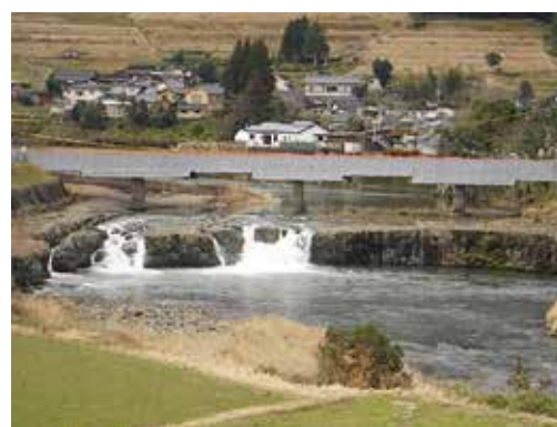
補修工事を実施する三日月の瀧の神幸橋
