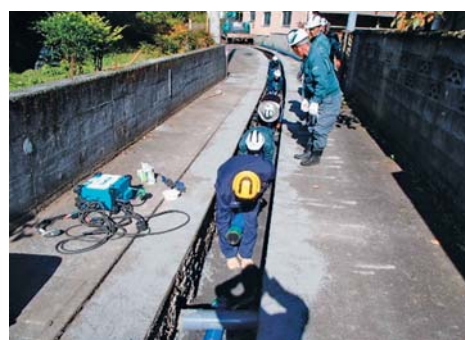
▲配水管敷設工事の状況
