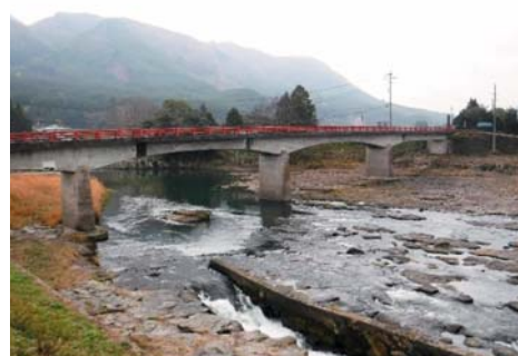
▲改良工事を実施する御幸橋
