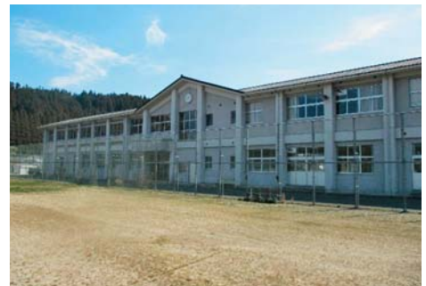
▲移転先の旧八幡中学校
