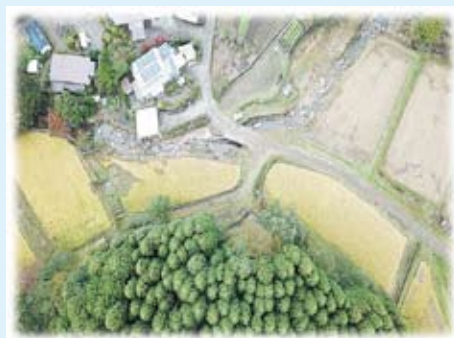
河川の被害状況
