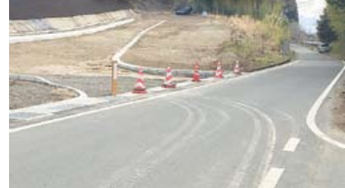
玖珠工業団地進入路建設事業 3億6316万円
