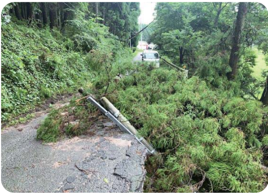
町道災害の状況
