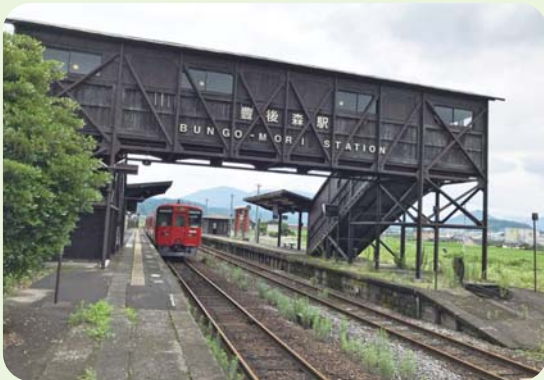
跨線橋・上り線は右側ホーム
