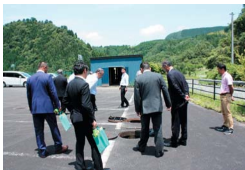
メルヘンの森ホッケー場の 水道施設の調査
