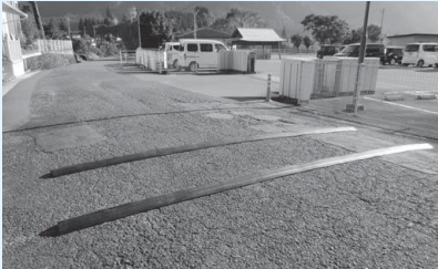
スピード抑制のためのベルト設置
