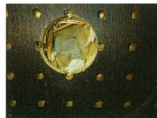
内壁隠蔽部 グラスウール
