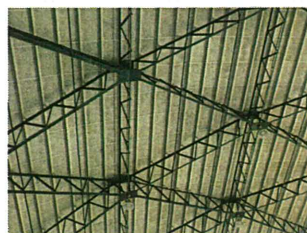
天井 木毛セメント板
