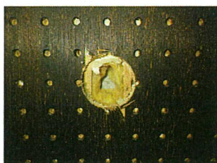
内壁隠蔽部 グラスウール
