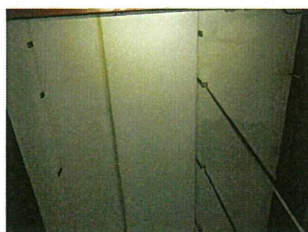
天井隠蔽部 A L C 板
