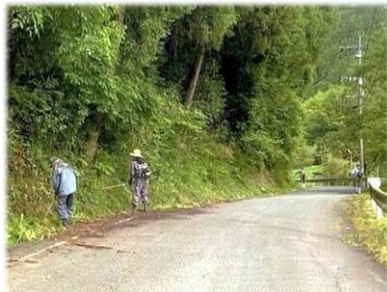
草刈り・側溝掃除(井川道)
