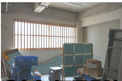
④倉庫（旧調理室）
