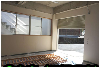
④倉庫（旧調理室）
