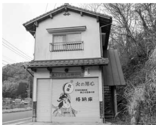
▲建て替え予定の第24部消防詰所
