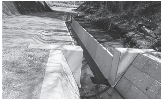
特定防衛施設周辺整備調整交付金事業 (小野原井路改修)
