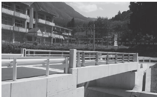
令和2年7月豪雨災害 春日橋橋梁災害復旧事業
