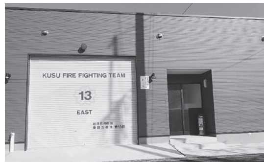
消防施設整備事業 (消防団第13部詰所建替事業)
