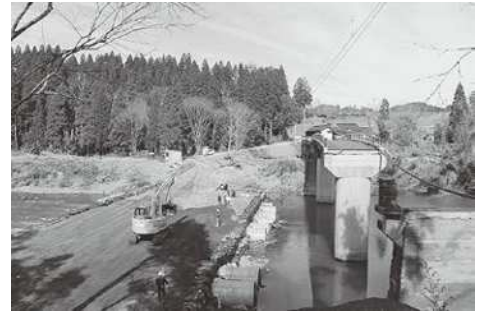
▲復旧工事中的の下泊里人道橋
