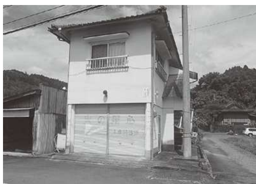
▲ 建て替え予定の第13部消防詰所
