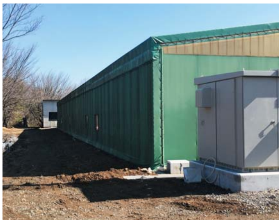
大字戸畑地区にある工場の外観
